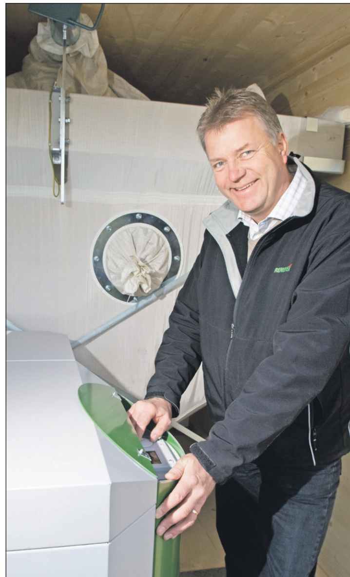
Kontrolpanelet sidder skjult under et lille vippelåg i kedlens forkant, som Andreas Reffs her demonstrerer. Via panelet kan man vælge forskellige indfyringsprogrammer, som fyret så følger automatisk.
