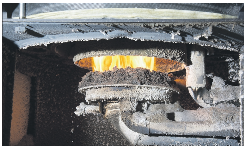
Brænderen er af "mulvarp"-typen. Stokersneglen presser træpillerne op i midten ligesom et mulvarpeskud. Deraf navnet.
